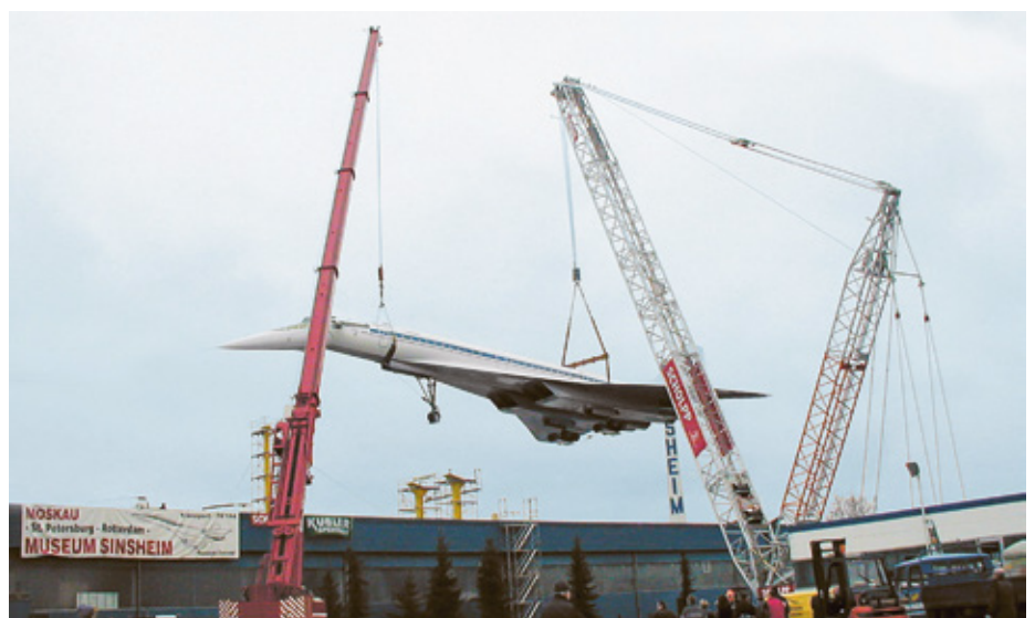
2001 wurde die 67 Meter lange und 100 Tonnen schwere Tupolev mithilfe eines Kran-Tandems auf das Dach der Halle 2 des Technik Museums Sinsheim gehievt
