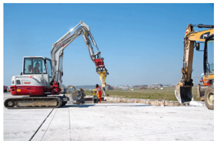
Auch Meißelbagger waren im Einsatz, um die 7,5 auf 7,5 Meter großen Betonplatten aufzubrechen
