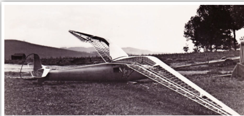
Ein Moazagotl-Rohbau in Grunau 1933
