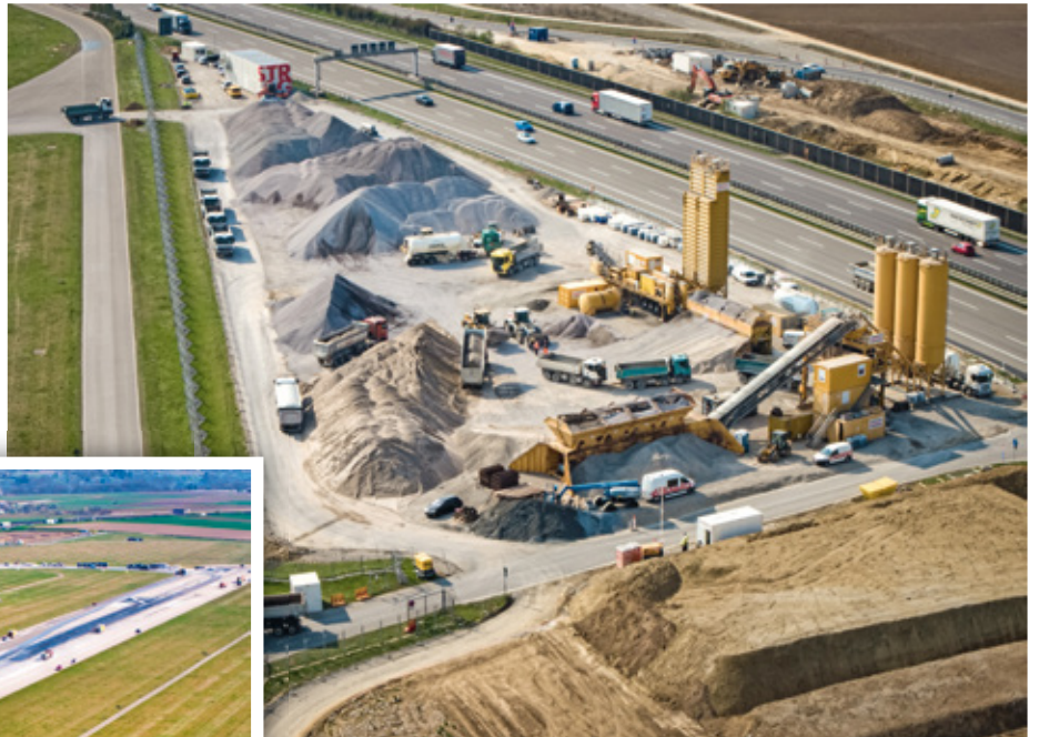
▲ Zwischen Flughafen und Autobahn wurde eigens für die Teilerneuerung der Runway ein Betonmischwerk gebaut
