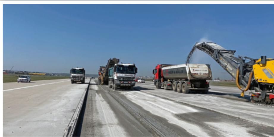
Mit riesigen Fräsen wurde die Betondecke abgetragen
