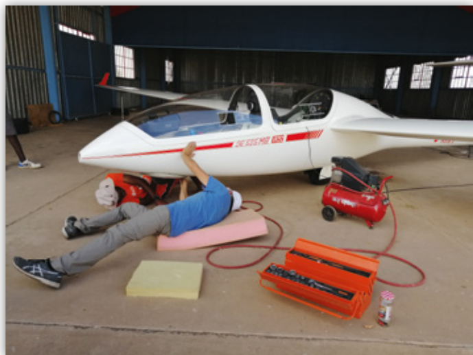
Drei Monate im Dauereinsatz machen die Wartung vor Ort unabdingbar. Improvisationskunst ist gefordert
