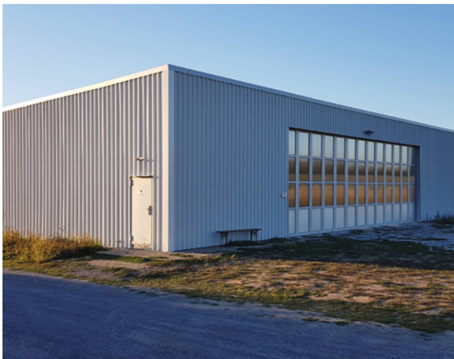
Die Halle wurde in Rekordzeit unter Beteiligung aller Vereine der Luftsportgemeinschaft gebaut
