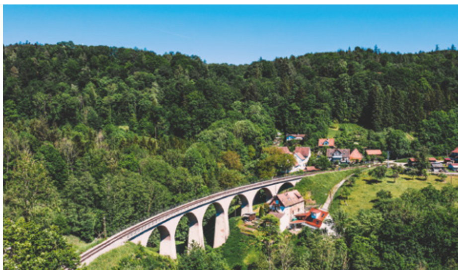
Das Strümpfelbach-Viadukt liegt idyllisch im Schwäbischen Wald. Dort verkehrt die Wieslauftalbahn
