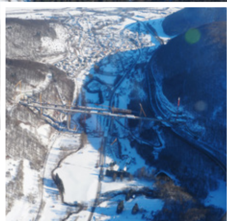
Blick auf die Bahn-Baustelle am Drackensteiner Hang
