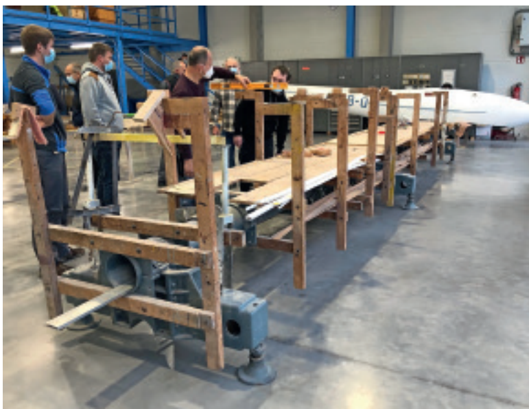
Die Helling wurde vorbereitet und eingerichtet, damit die reparierte Tragfläche später nicht krumm und schief wurde
